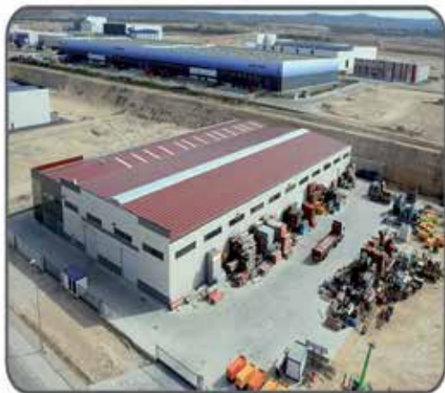
Centro Logístico de Maquinaria
